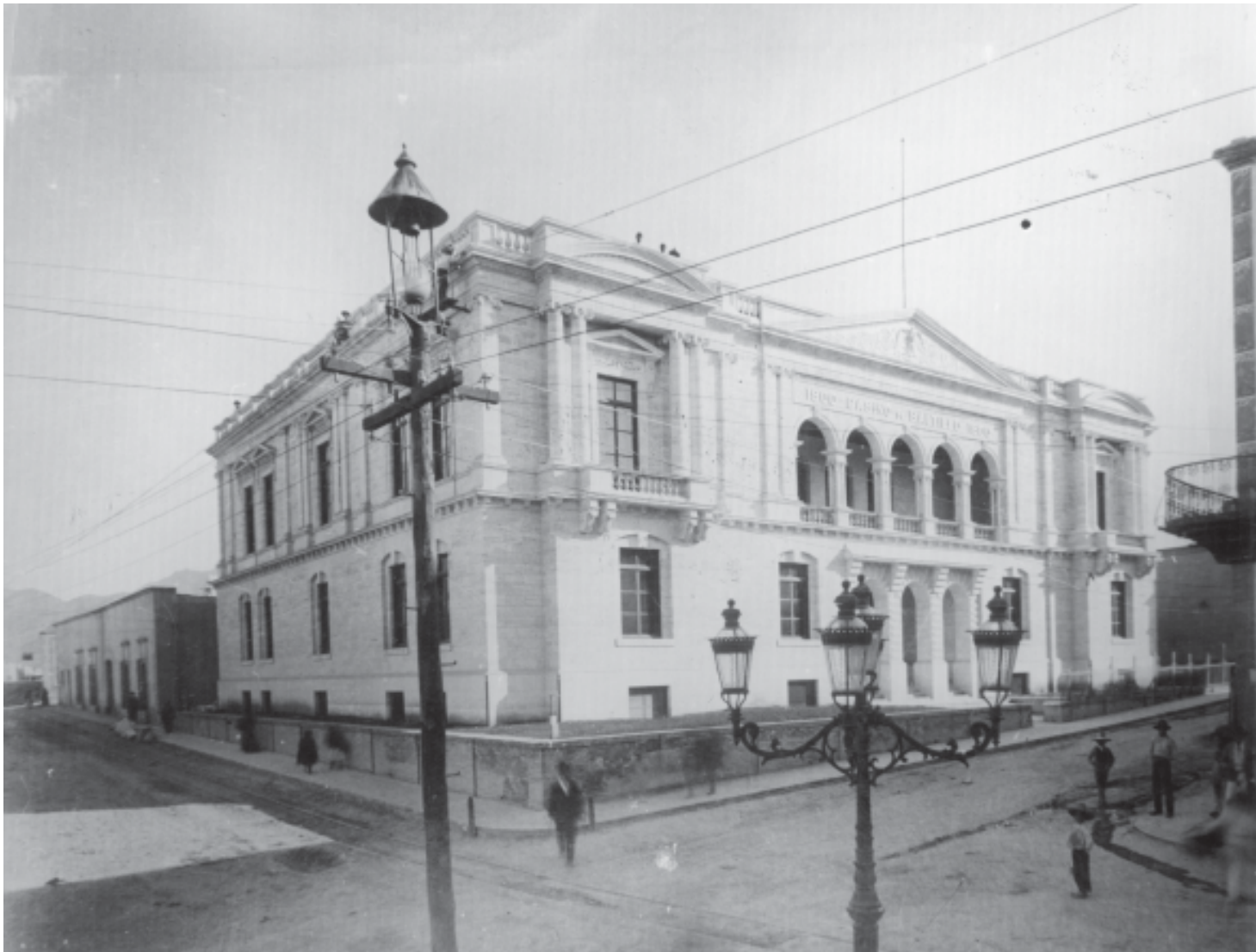
Casino de Saltillo, en los primeros años del siglo XX. Fototeca del AMS, C7-P21-F32. Nótese las farolas de gas y los rieles del tranvía de mulitas que pasaba por ahí en su diario recorrido por la ciudad.
