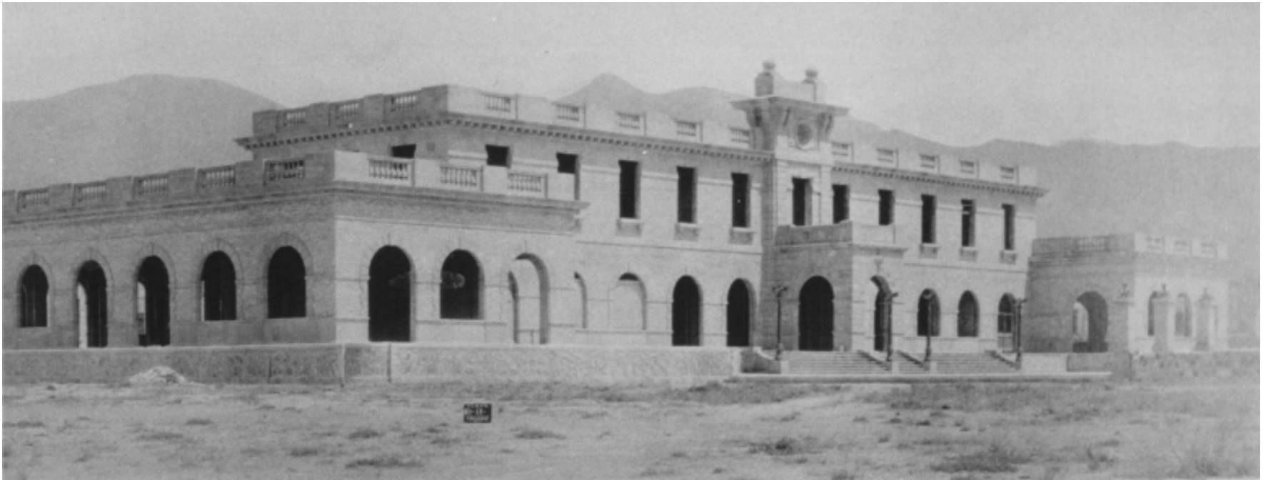
Edificio que ocupa actualmente el Archivo Municipal de Saltillo, ca. 1920.
