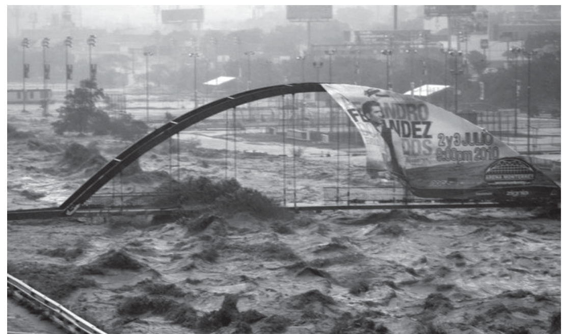
Inundación del huracán Alex. Monterrey, 2010.
